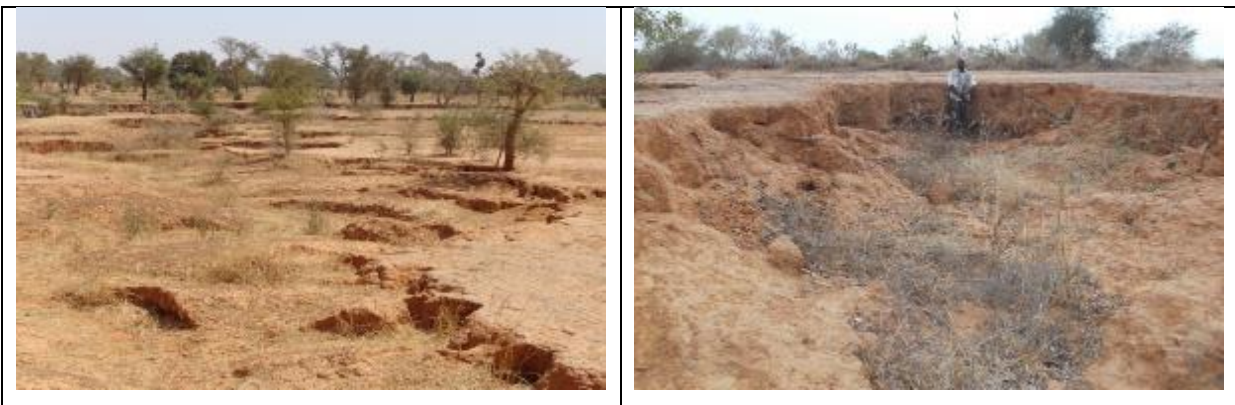
Photo 7 : Ravinement des terres amonts de retenues d'eau
