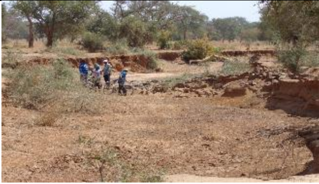
Photo 4 : elargissement des berges de cours d'eau
