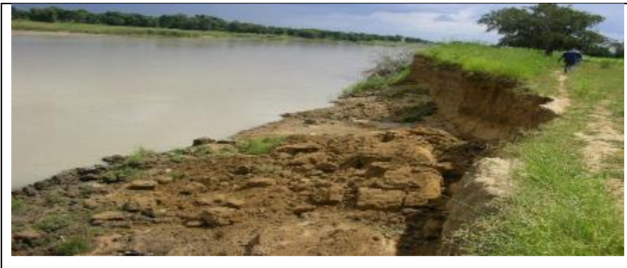
Photo 6 : eboulement des talus de berges
