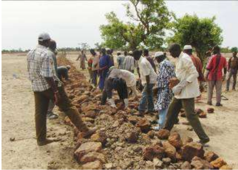
Photo 12 : Confection d'une Digue ( Source: SOS Sahel International, 2008 )
