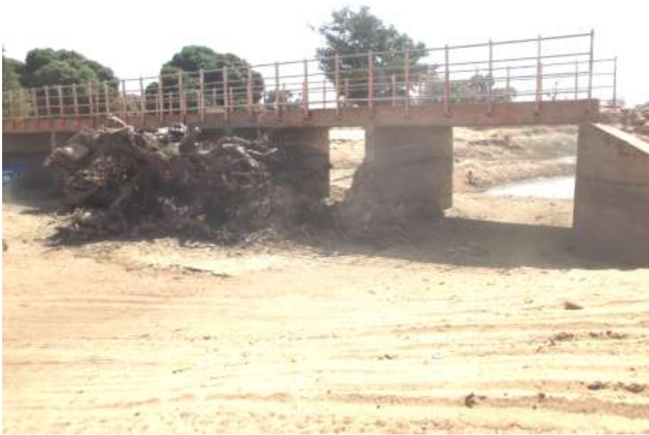
Photo 2 : Tronc d'arbre retenu par un pont. Photo d'un pont dans le village de Boussouma dans la province du Boulgou (kambiré SH, 2014)
