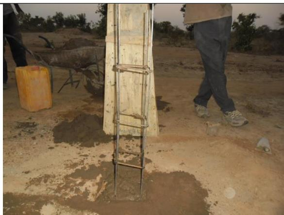
Photo N°6 : Ferrailage d'une balise
