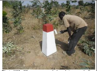
Photo N°8: Mise en œuvre de la peinture sur balise
