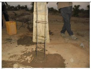
Photo N°6 : Ferraillage d'une balise
